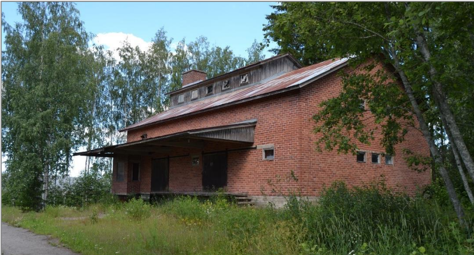
Kuva 54. Rakennus kuvattuna kaakkoiskulmalta.
