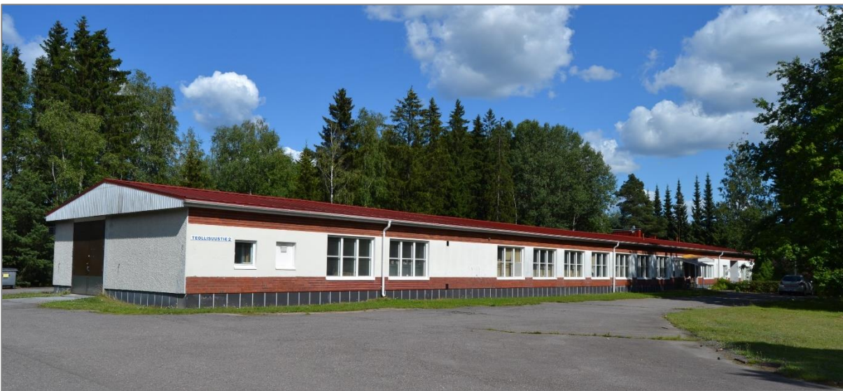
Kuva 60. Entisen kenkätehtaan länsipääty ja eteläsivua.
