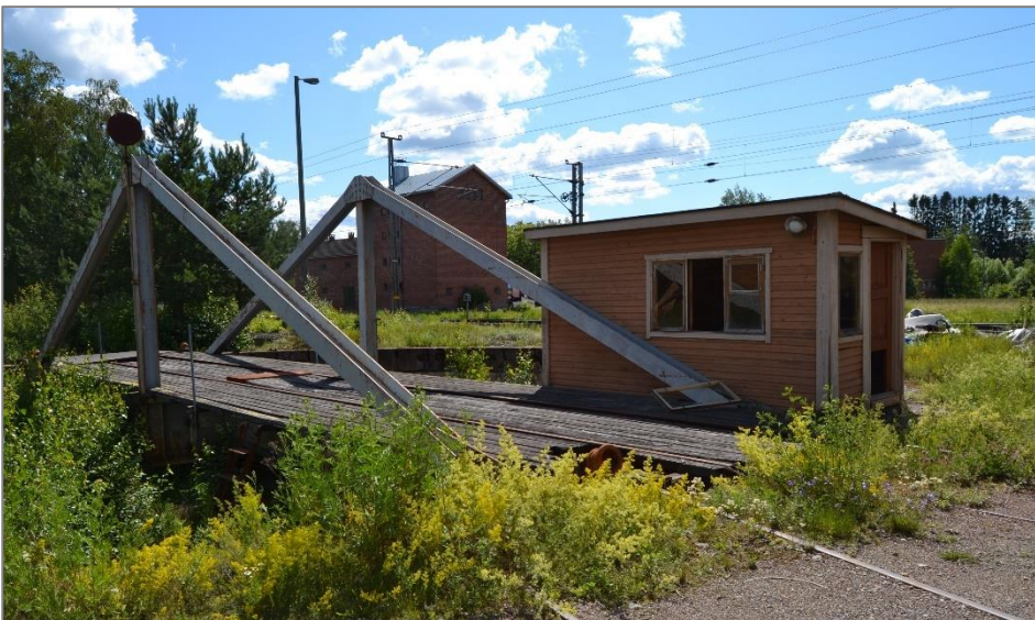
Kuva 23. Veturitallien edessä on säilynyt kääntöpöytä, jolla veturit on ohjattu oikeisiin pilttuisiin.
