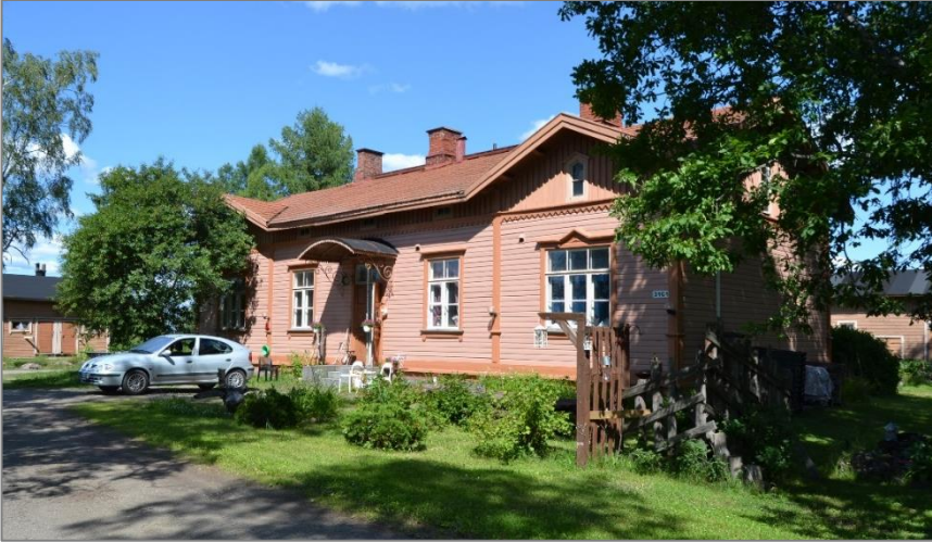
Kuva 26. Asuinrakennuksen radanpuoleinen julkisivu kuvattuna kaakosta.
