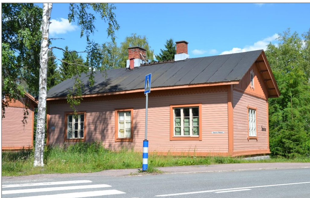
Kuva 33. Sauna- ja pakarirakennus kuvattuna Köyliöntieltä. Kuvassa rakennuksen radan puoleinen sivu.
