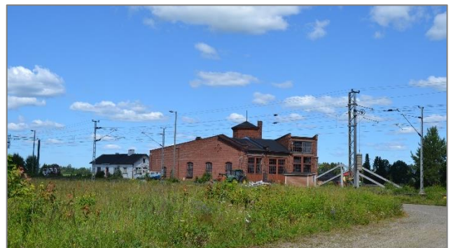
Kuva 7. Veturitallit kuvattuna radan yli. Kuvaussuunta luoteeseen.
