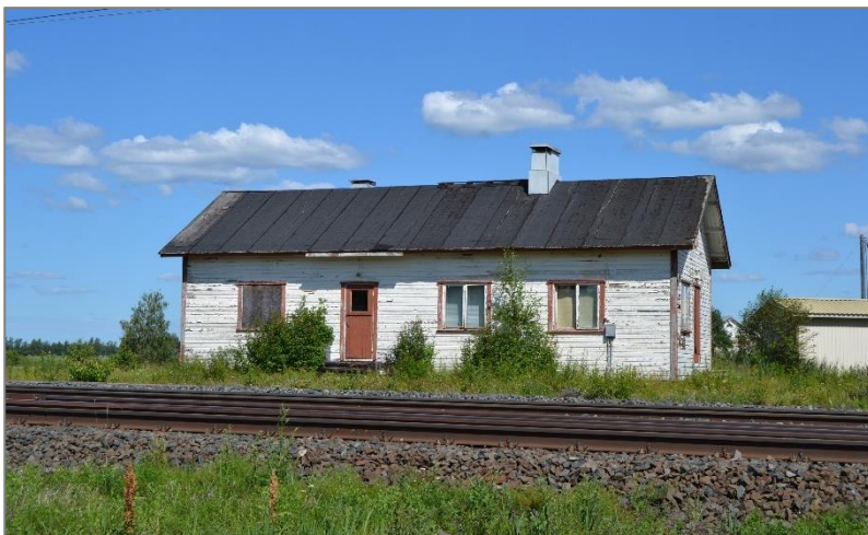
Kuva 21. Toimistorakennuksen eteläsiivu kuvattuna radan takaa.
