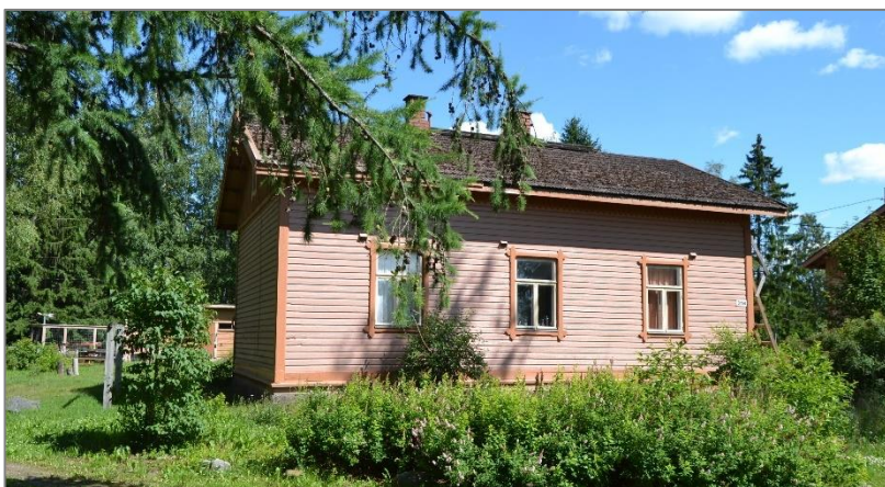
Kuva 31. Asemamiehen asunnon radan puoleinen sivu.
