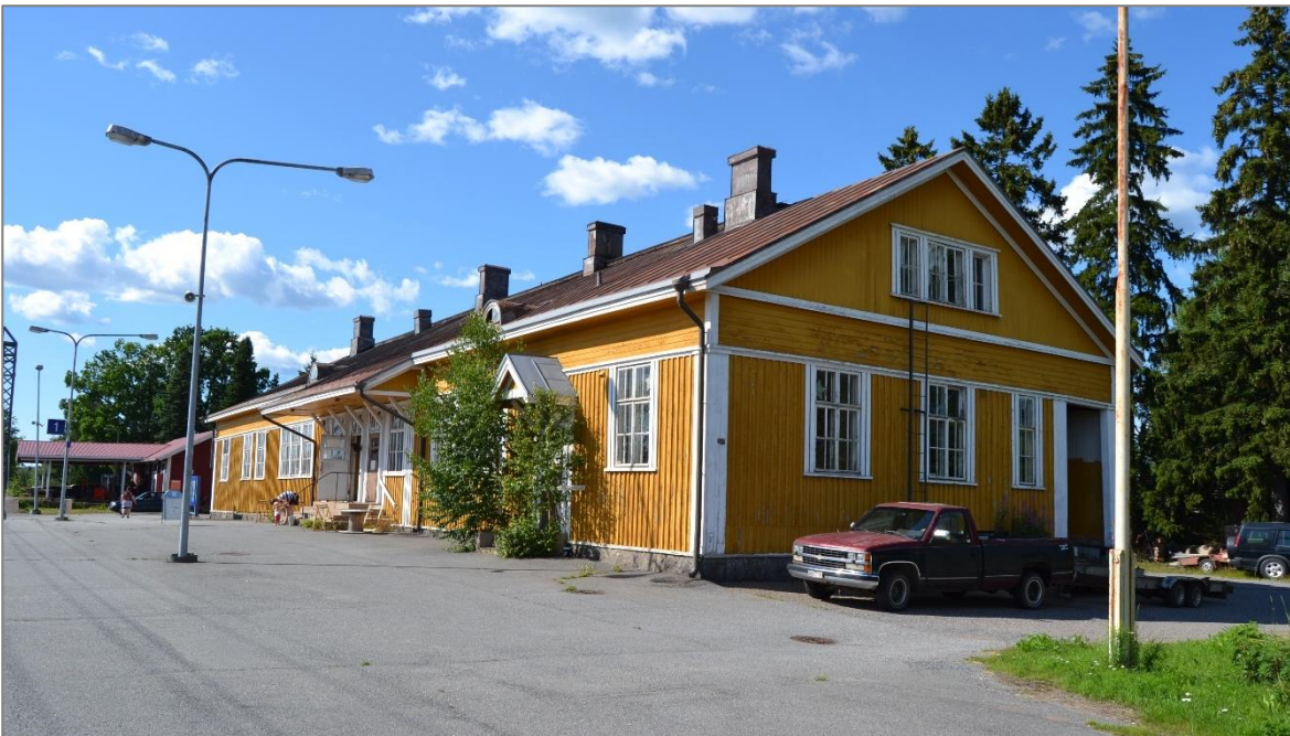
Kuva 47. Asemarakennuksen radan puolen pääjulkisivu ja itäpäätty.
