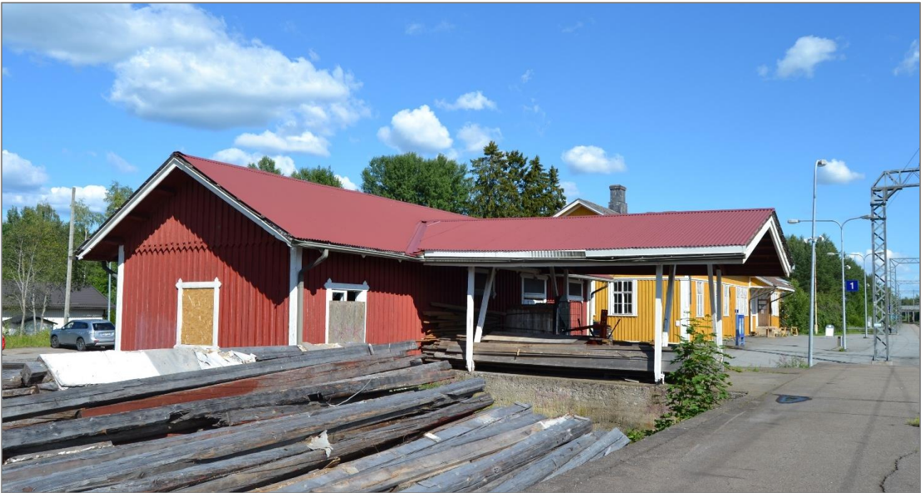
Kuva 44. Tavarasuoja kuvattuna lännen suunnasta. Taustalla näkyy asemarakennus.
