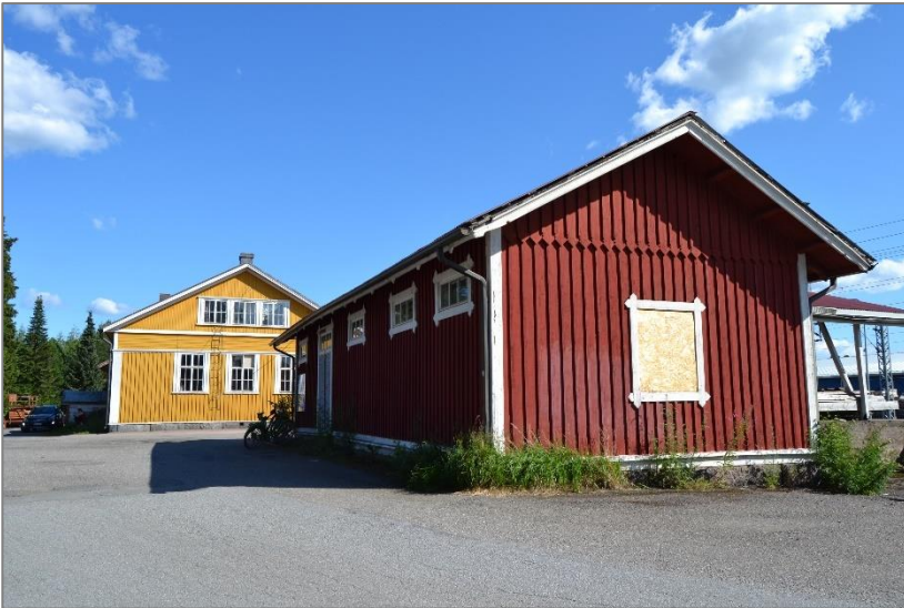
Kuva 14. Kuva Peipohjan asemalta. Etualalla tavarasuoja, takana asemarakennus.
