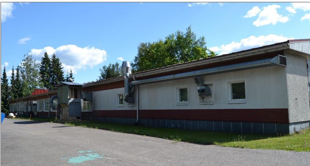
Kuva 59. Entisen kenkätehtaan rakennuksen pohjoissivua.
