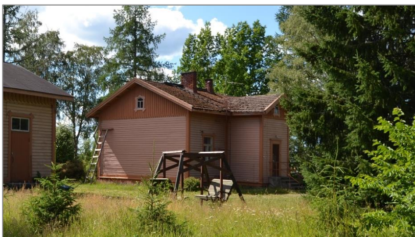
Kuva 30. Asemamiehen talo kuvattuna pihan puolelta idästä, Opistontien varrelta.
