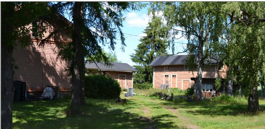
Kuva 28. Asuinrakennuksen eteläpääty ja ulkorakennukset, kuvaussuunta pohjoiseen.
