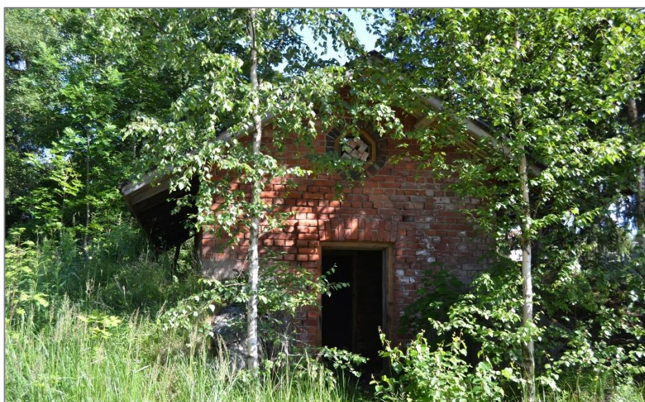
Kuva 45. Aseman takana sijaitsevan tiilikellarin länsipääty.
