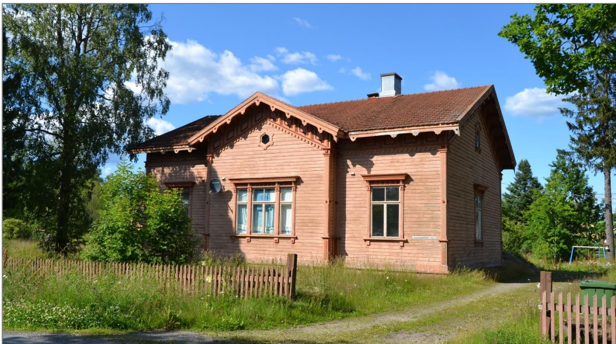
Kuva 43. Asemapäällikön talo kuvattuna radan puolelta Asemakujalta.
