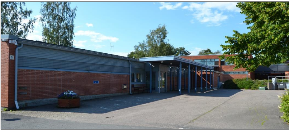
Kuva 13. Uimahallin itäisivua. Sisäänkäynnin katos on tehty 2000-luvulla.
