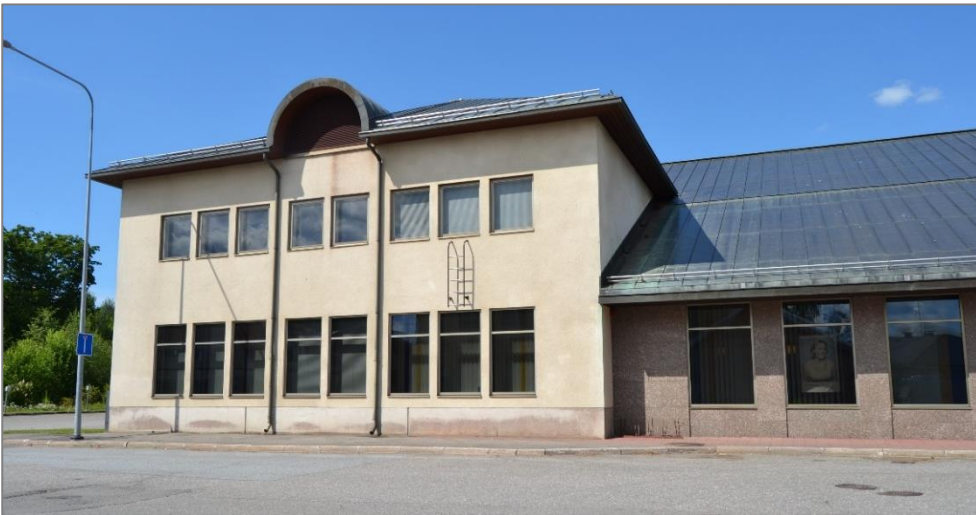
Kuva 23. Rakennuksen itäisivua kuvattuna Teljäkadulta.
