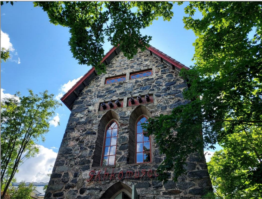
Kuva 3. Seuratalonrinteessä sijaitseva muuntamo vuodelta 1922 kuuluu arvoluokka A:han. Muuntamo on myös maakunnallisesti merkittävä kohde.
