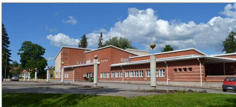
Kuva 34. Rakennus kuvattuna Satakunnantien puolelta.
