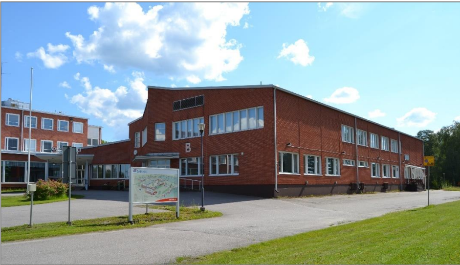
Kuva 33. Kuvan rakennusosa valmistui vuonna 1990 ravintotalous- ja vaatetusosastoksi.
