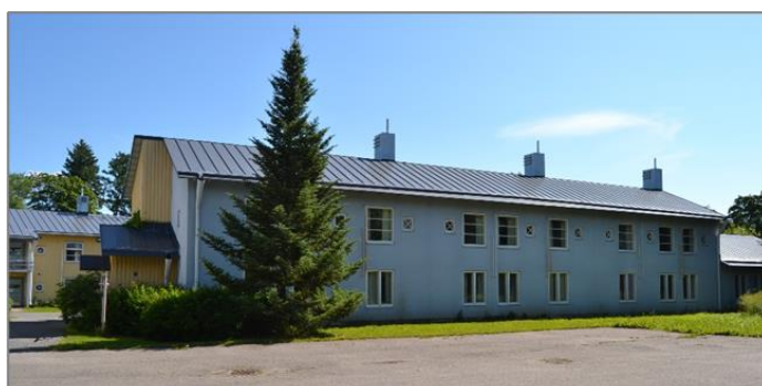
Kuva 39. Oppilasasuntolan länsijulkisivu parkkipaikalle päin. Asuntojen julkisivuissa on käytetty rapattuja harkkoja ja pystyrimalaudoitusta.
