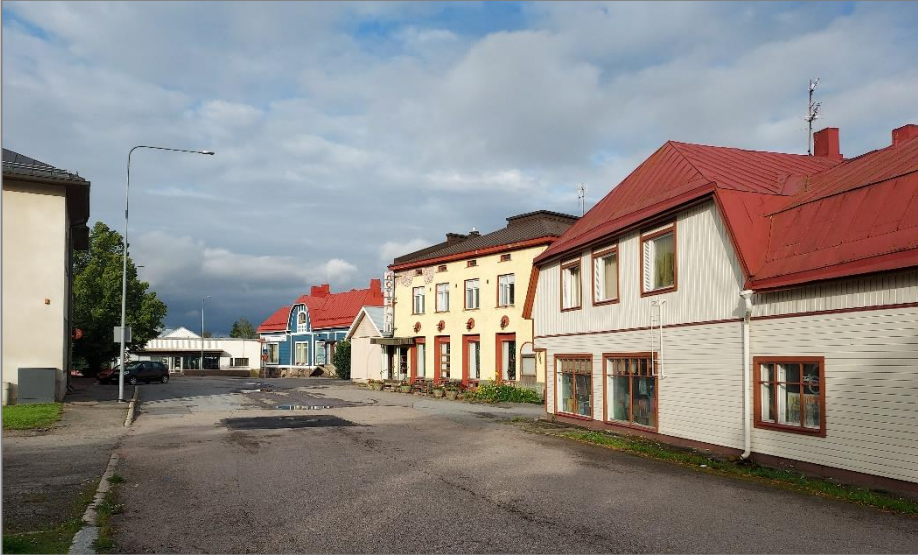
Kuva 5. Teljänkadulla säilynyttä rakennuskantaa Tulkkilan vanhassa keskustassa. Kuvassa oikealla on 1900-luvun alun räätälin asuin- ja liikerakennus Pukimo, jonka takaa näkyy vuonna 1931 valmistunut Hotelli Seurahuone. Taaimmaisena näkyvä sininen puurakennus on Rohtola, joka valmistui 1908.
