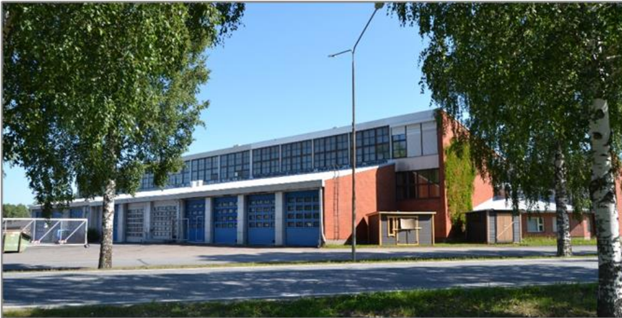
Kuva 17. Viinikan rekkahalli kuvattuna Satakunnantieltä heinäkuussa 2023, kuvaussuunta koilliseen.
