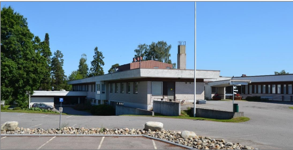
Kuva 28. Alkuperäinen rakennusosa sijoittuu kuvan keskelle. Vasemmalla näkyvä matala siipi on ensimmäinen laajennus vuodelta 1971. Vuonna 1979 valmistunut siipiosa näkyy kuvassa oikealla. Pääsisäänkäynnin edessä on veistoksellinen, valettu katos.
