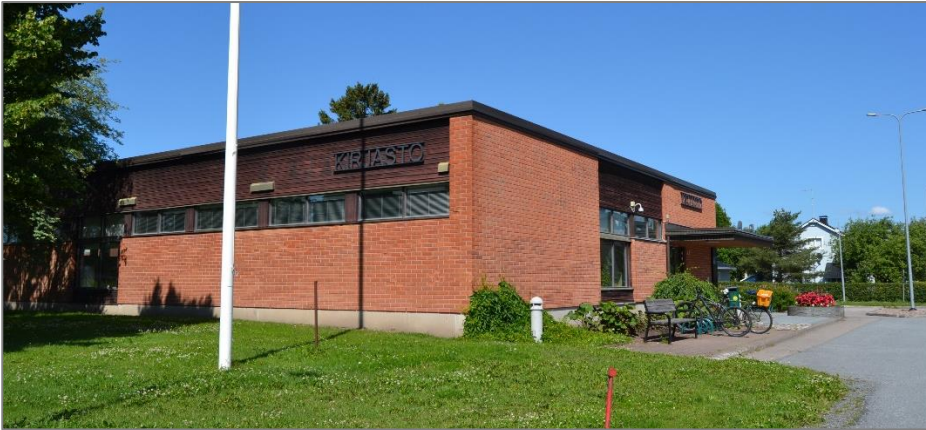
Kuva 12. Kirjastorakennus kuvattuna kaakkoiskulmalta heinäkuussa 2023.
