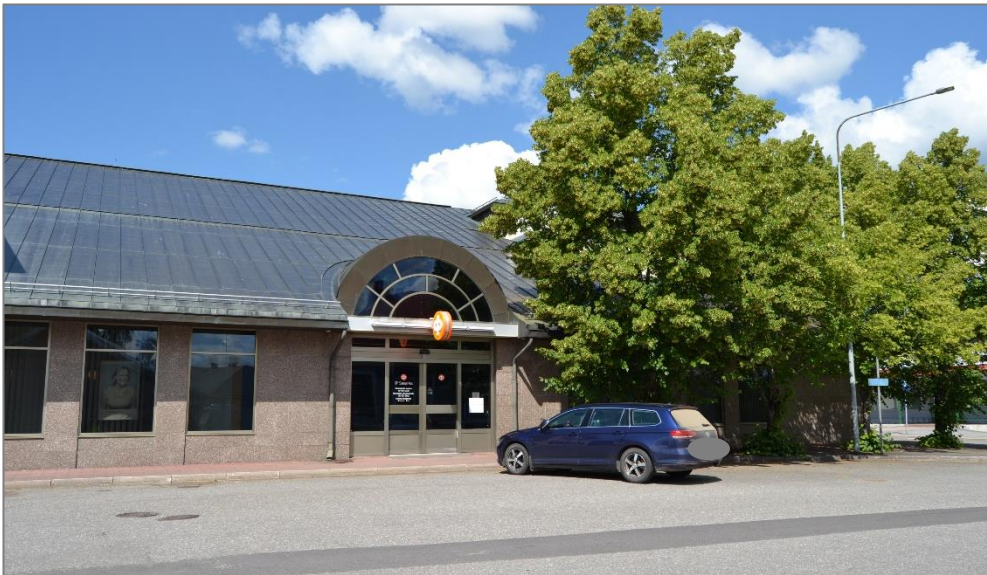
Kuva 26. Kuva rakennuksen itäisivulta, Teljänkadun sisäänkäynniltä.
