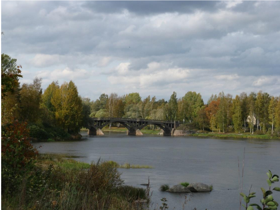
Kuva 11. Kokemäenjoen ylitse johtaa Tulkkilan kohdalla 1918 rakennettu kolmiaukkoinen teräsbetoninen kaarisilta.
