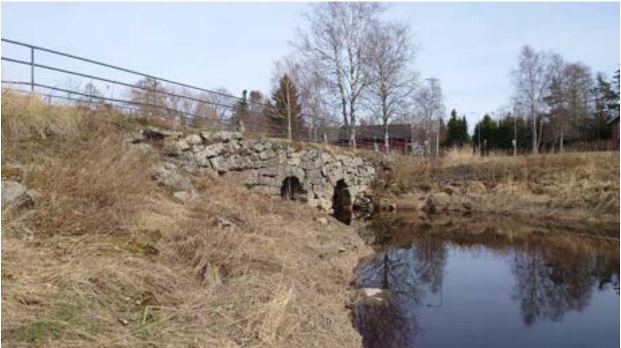
Kuva 55. Sillan eteläpuoli. Koilliseen. KL.
